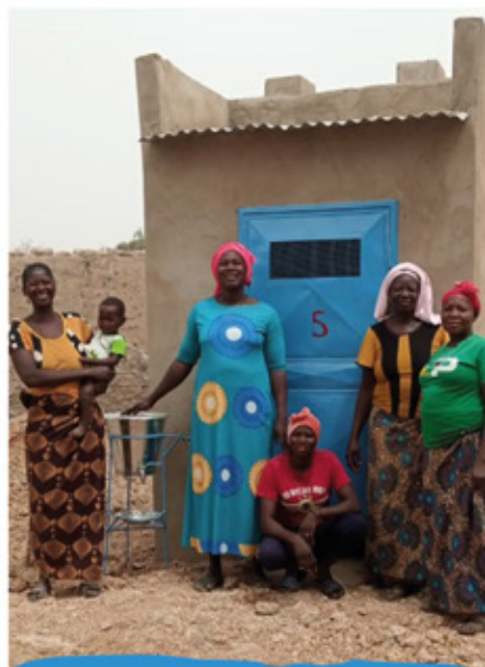
DorfbewohnerInnen vor der neu errichteten Kompostlatrine in Doulougou.
